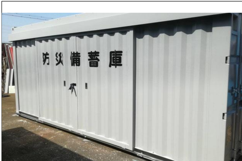
①備蓄倉庫
