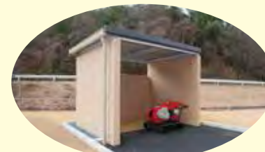
堆肥化ヤード
