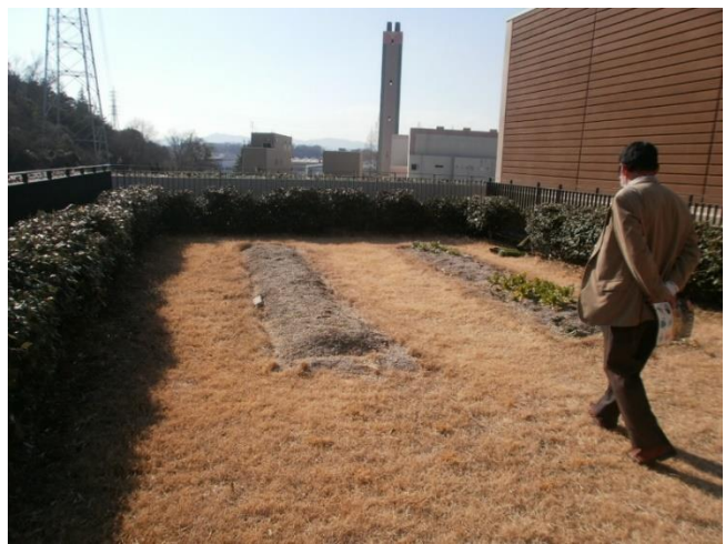
⑨屋上緑化スペース
