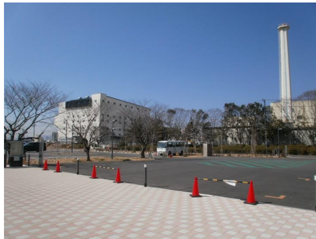
⑯施設の外観
