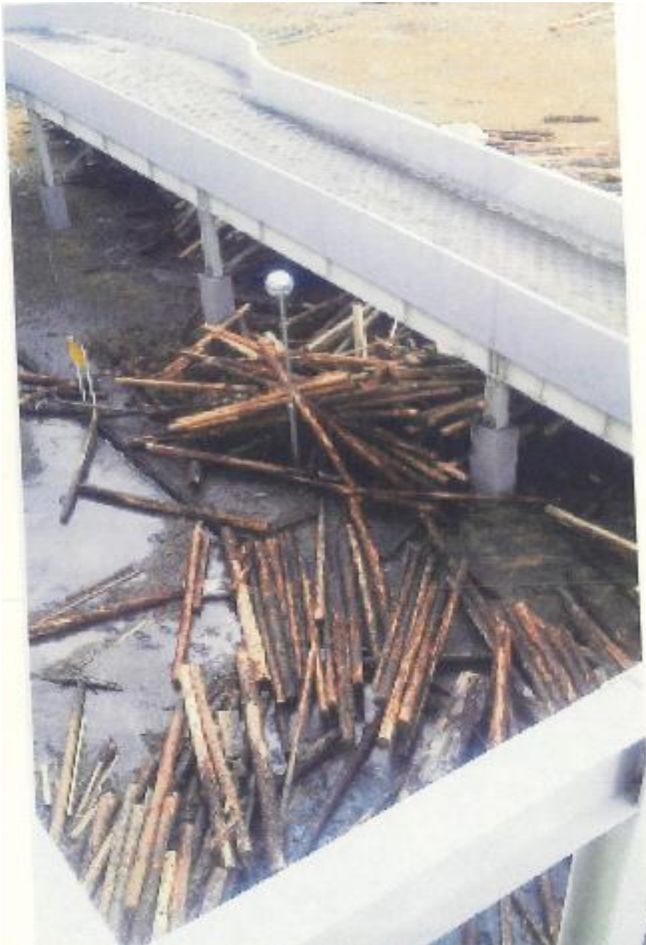
津波が引いた後、 ランプウェイ下に残った流木 (神鋼環境ソリューション撮影)
