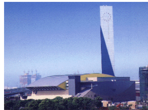
有明清掃工場
